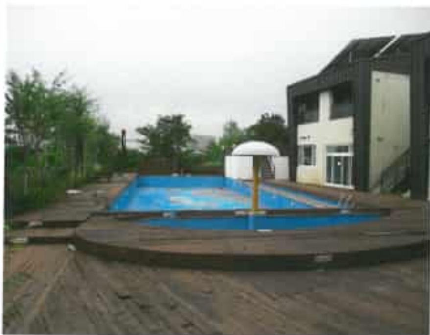
구축물 (수영장) - 전경
