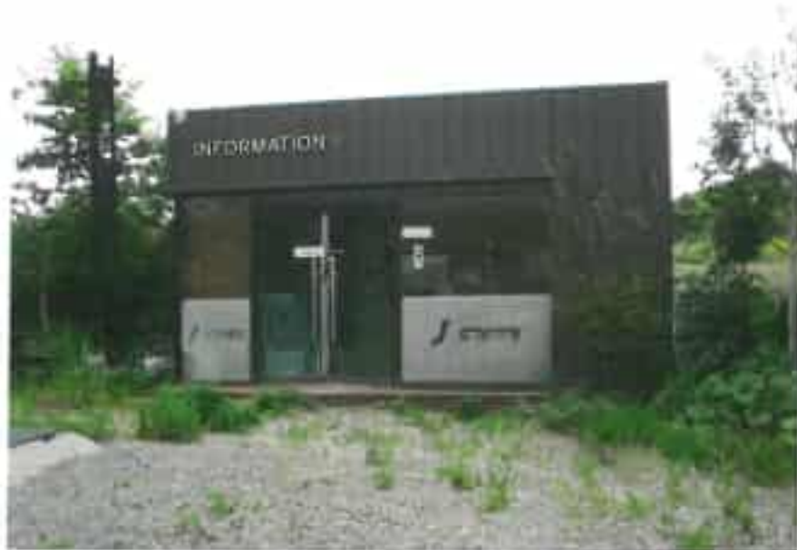
부합물 및 증물 기호 ㄱ - 전경
